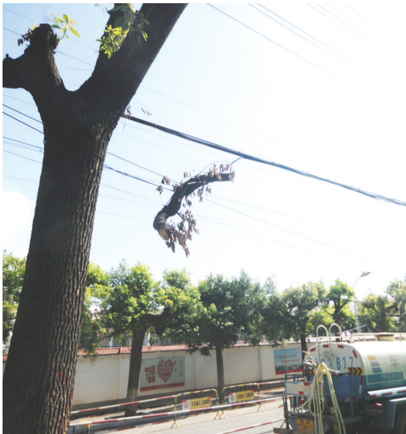
图为市府路上电线下地。徐勇进 摄
